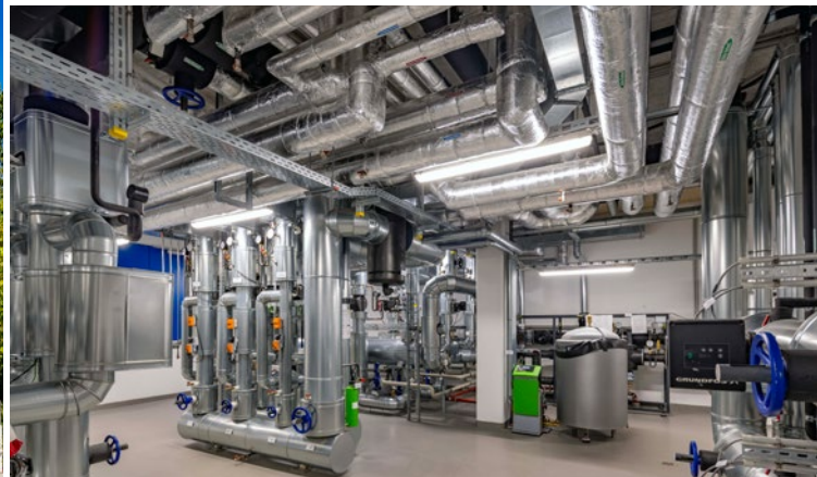
Beim Büro- und Geschäftshaus Neue Siederei in München nutzte DS elektrotherm BIM für Heizung, Sanitär, Lüftung, Kälte-/Klima- und Gebäudeleittechnik.
