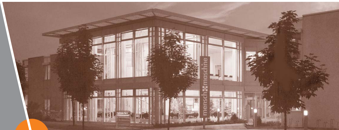
Die MuM-Firmenzentrale in Wessling bei München
