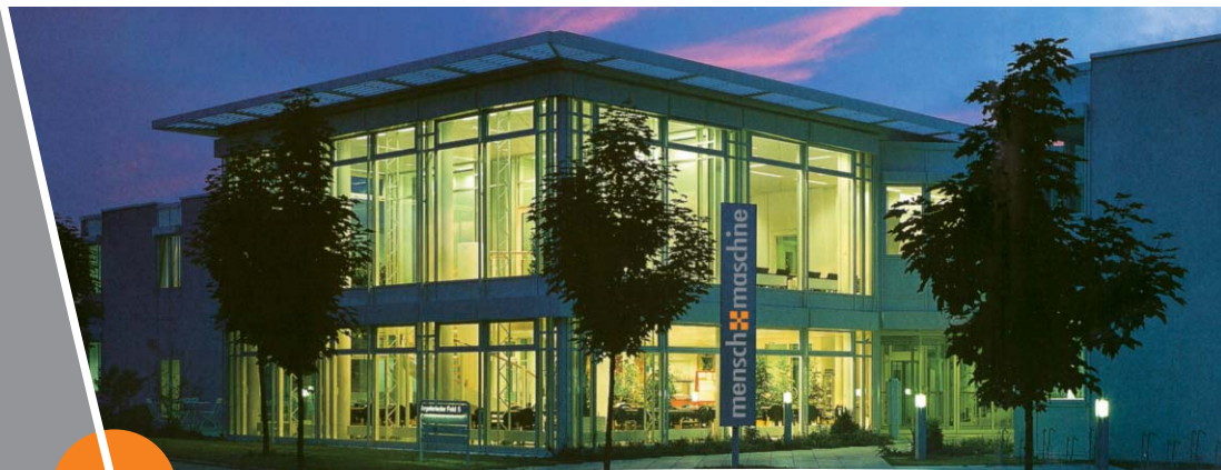
Die MuM-Firmenzentrale in Wessling bei München
