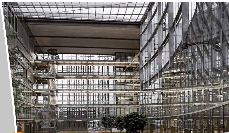
Aussicht und Austausch: Der Raum für Pausen und informelle Treffen. Das hohe Dach und die Glasfronten laden die Gedanken ein, neue Wege zu gehen. Hier wurde auch die Idee geboren, aus Revit Architecture ein Facility Management zu machen. Foto: Rainer Viertlbock
