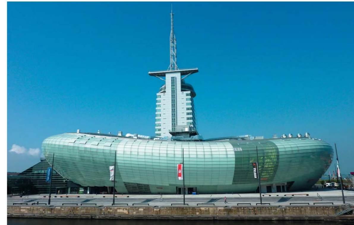
Die Vorteile der 3D-Planung mit AutoCAD Architecture wurden vor allem für das Klimahaus Bremerhaven genutzt: Über die 125 Meter lange und 82 Meter breite Innenkonstruktion aus Beton wölbt sich eine futuristisch geschwungene Hülle aus Glas. (© Foto: agn)
